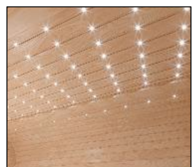
LED Decken- Beleuchtung
